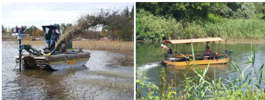
Εικόνα 25. (α) Το μηχάνημα Aquarius Truxor σε λειτουργία απομάκρυνσης ιζήματος, (β) πλωτό μηχάνημα συλλογής υδροφύτων
